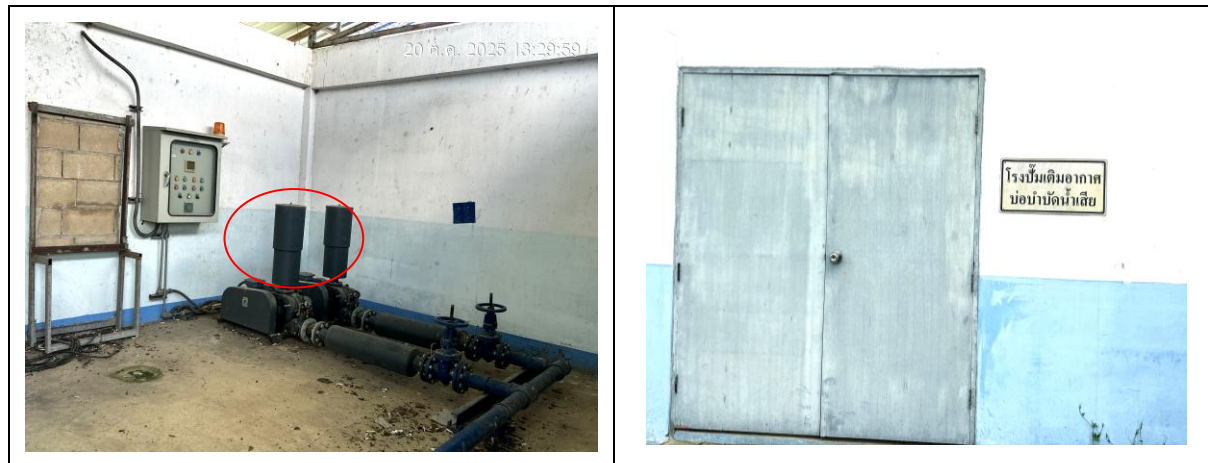
รูปที่ 1 บั้มเติมอากาศสำหรับระบบบำบัดน้ำเสีย
