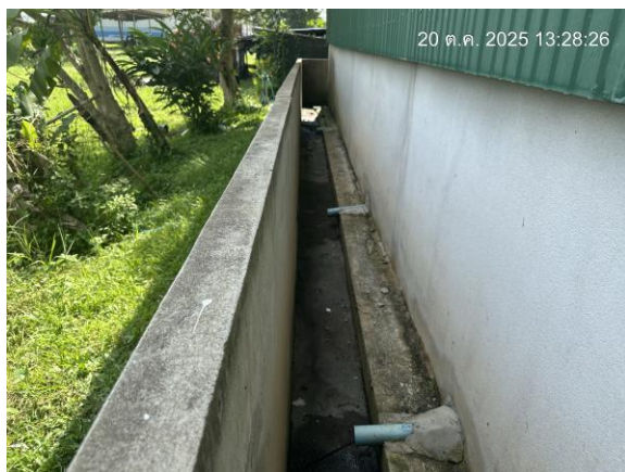
รูปที่ 14 รางระบายน้ำรอบอาคารพักขยะ
